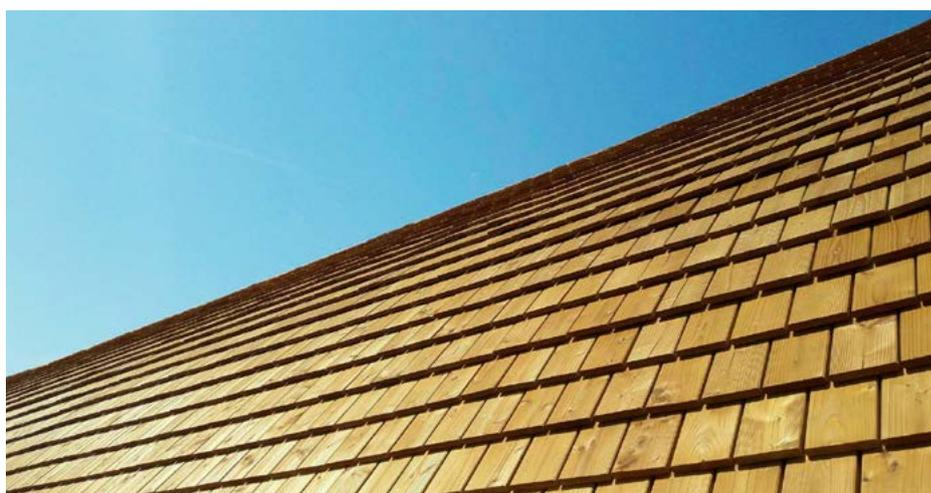
▲ Plus de 9500 bardeaux de bois massif sont utilisés ici pour couvrir la surface de la toiture
